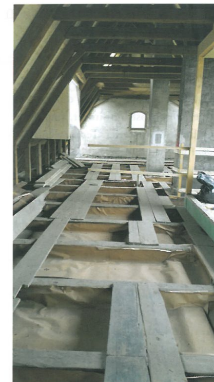
VORBEREITUNG DER BAUSTELLE. Einbringen von Thermo-Baupapier als Windbruch und Rieselschutz
