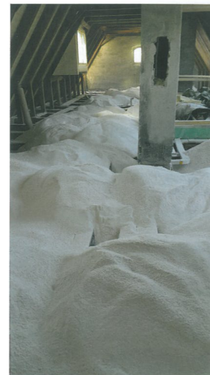
EINFACH. Nach dem Einblasen der Dämmschüttung. Jetzt nur noch mit einer Latte verteilen – und fertig.
