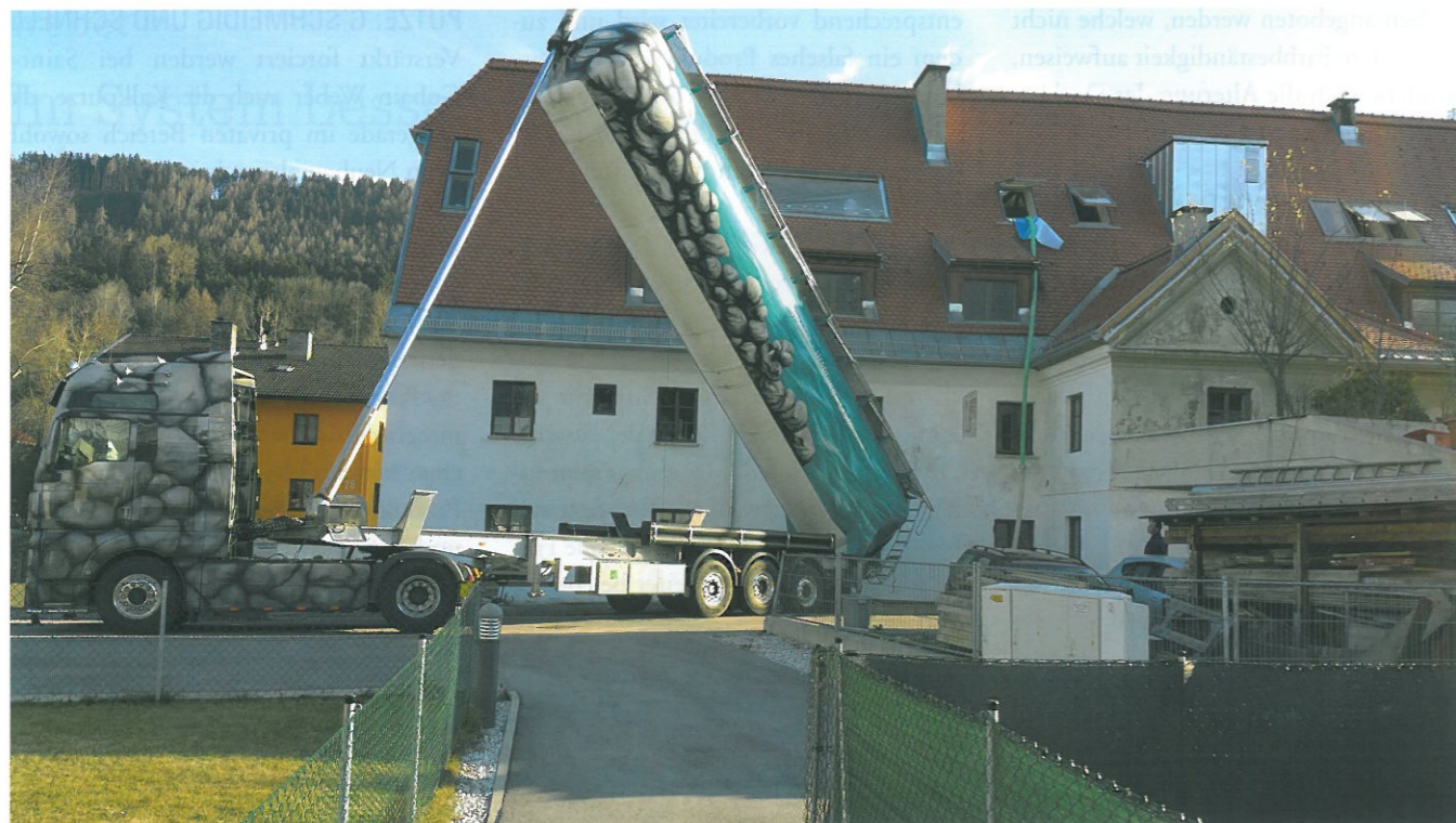
URBAN. Die Baustelle mitten in Hall in Tirol.
